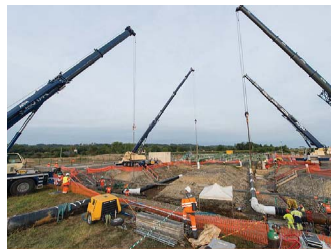
Opération de raccordement à Mont.
