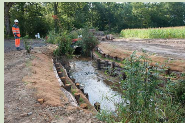
Remise en état des berges du Lech.
